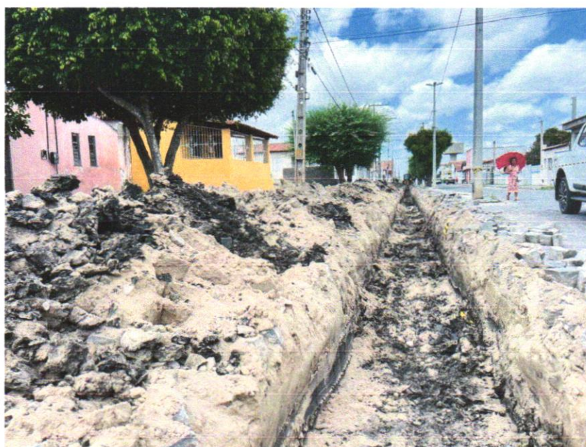
Foto 03 - ESCAVAÇÃO DE VALA
