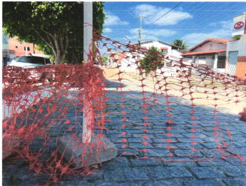
Foto 01 – Tapume de proteção em tela de polietileno h=1,20 com bloco de concreto
