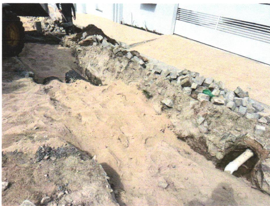
Foto 05 - ATERRO MANUAL COM SOLO ARGILO-ARENOSO IMPORTADO E COMPACTAÇÃO MECANIZADA EM CAMADAS DE 0,20 M NO MÁXIMO
