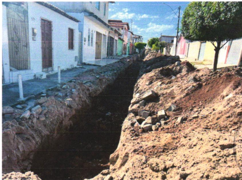
Foto 02 – ESCAVAÇÃO DE VALA
