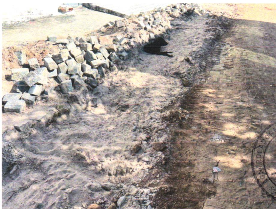
Foto 04 - ATERRO MANUAL COM SOLO ARGILLO-ARENOSO IMPORTADO E COMPACTAÇÃO MECANIZADA EM CAMADAS DE 0,20 M NO MÁXIMO
